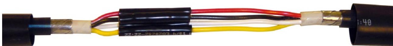
Einzeladern und Kabelmantel fettfrei reinigen.
