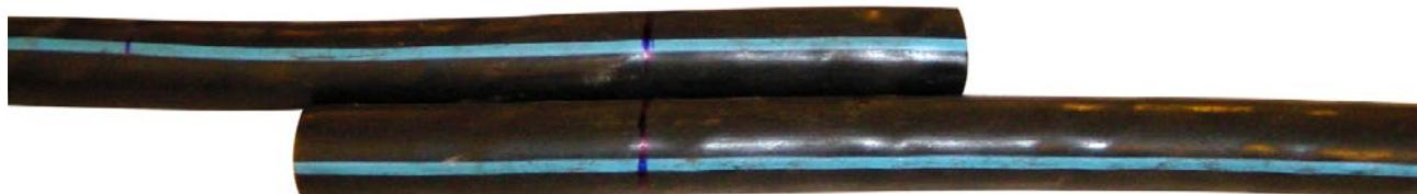
Kabelenden auf einer Länge von ca. 900mm reinigen und entfetten.
