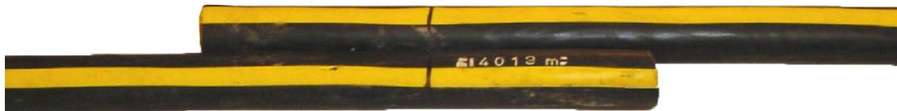
Kabelenden auf einer Länge von ca. 900 mm reinigen und entfetten.
