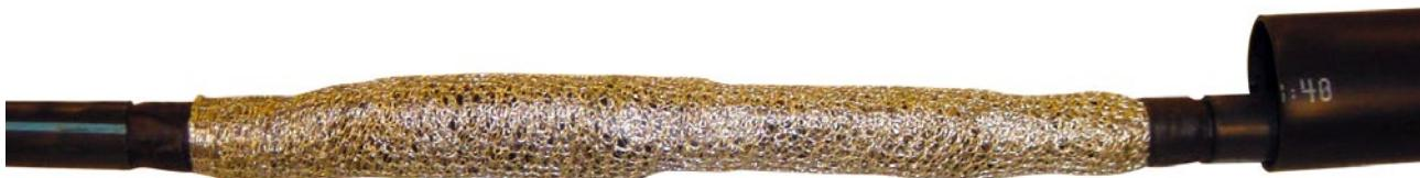
Nach gutem Abkühlen der Zwischenmuffe, Kupfergewebeband halb überlappend über den ganzen Bereich der Muffenlänge "c" wickeln. An den Übergängen auf die CL-Armierung das Kupfergewebeband mit drei Lagen selbstvulkanisierendem Isolierband (optional: mit Kontaktrollfedern) gut fixieren.
