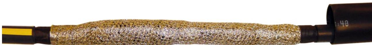
Nach gutem Abkühlen der Zwischenmuffe, Kupfergewebeband halb überlappend über den ganzen Bereich der Muffenlänge "c" wickeln. An den Übergängen auf die CL-Armierung das Kupfergewebeband mit drei Lagen selbstvulkanisierendem Isolierband (optional: mit Kontaktrollfedern) gut fixieren.
