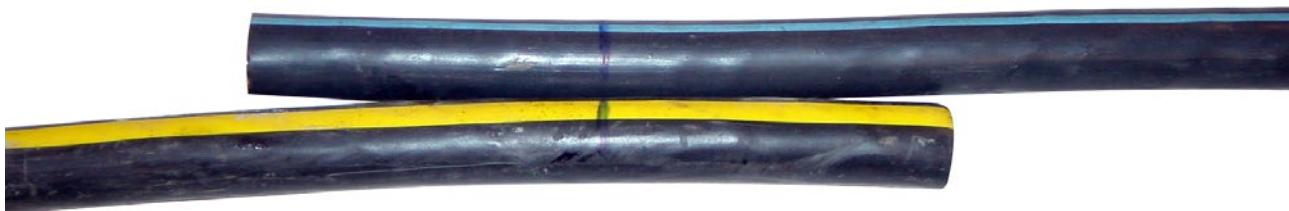
Kabelenden auf einer Länge von ca. 900mm reinigen und entfetten.
