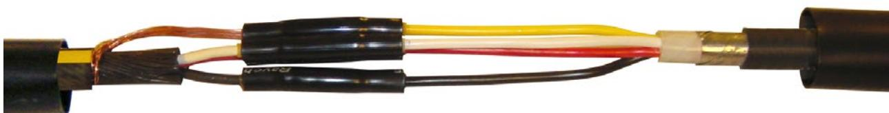
Einzeladern und Kabelmantel fettfrei reinigen.
