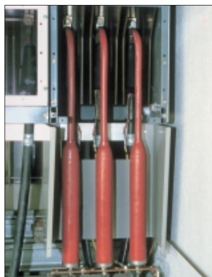
Installation de commutation Siemens 8DJ10 avec déviateurs de surtension RDA pour intérieur et boîtes d'extrémité Raychem.
