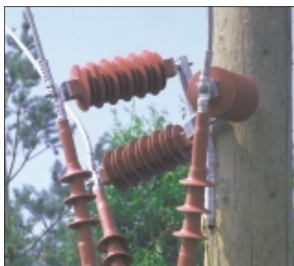
Les déviateurs de surtension en oxyde métallique SPA-I sont la solution idéale pour rééquiper des installations de couplage isolées de l'air ambiant et de corps étrangers.
